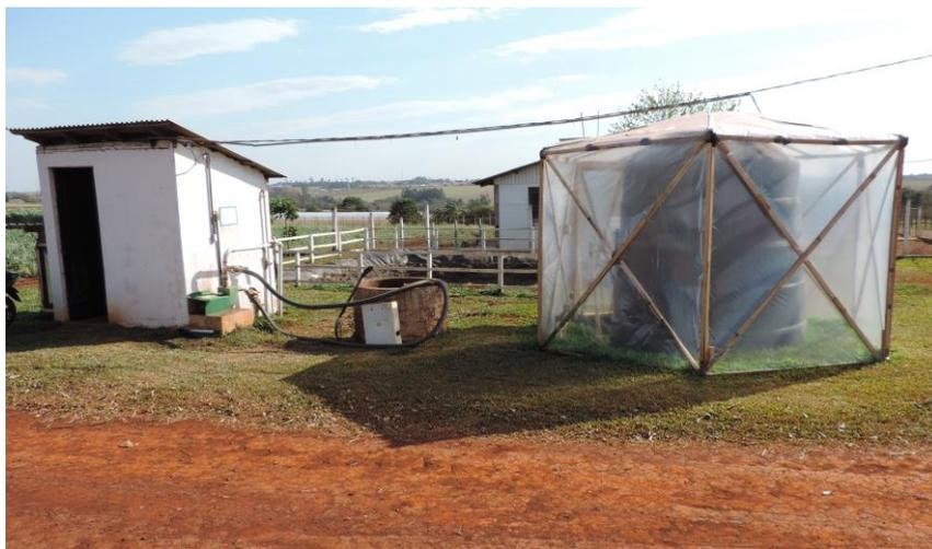
**Figura 1.** Câmara de biodigestão coberta pela estufa plástica.
