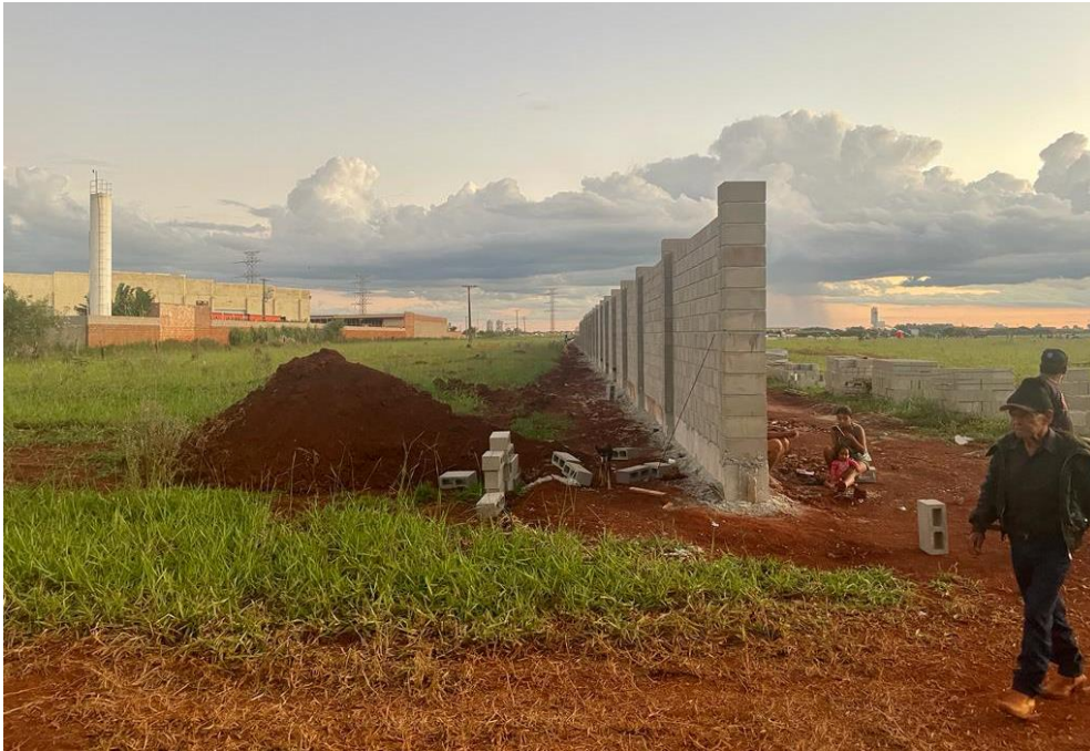
Fotografia 1 – Construção do muro de condomínio de luxo em área reivindicada pelos Guarani e Kaiowá, em Dourados/MS.
