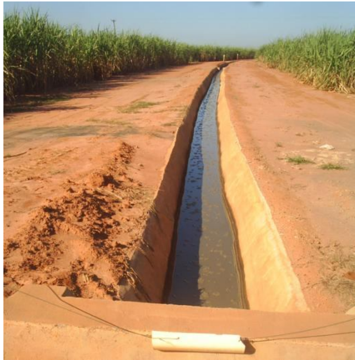
Foto 3 - Canaleta que distribui o vinhoto no plantio de cana de açúcar.
