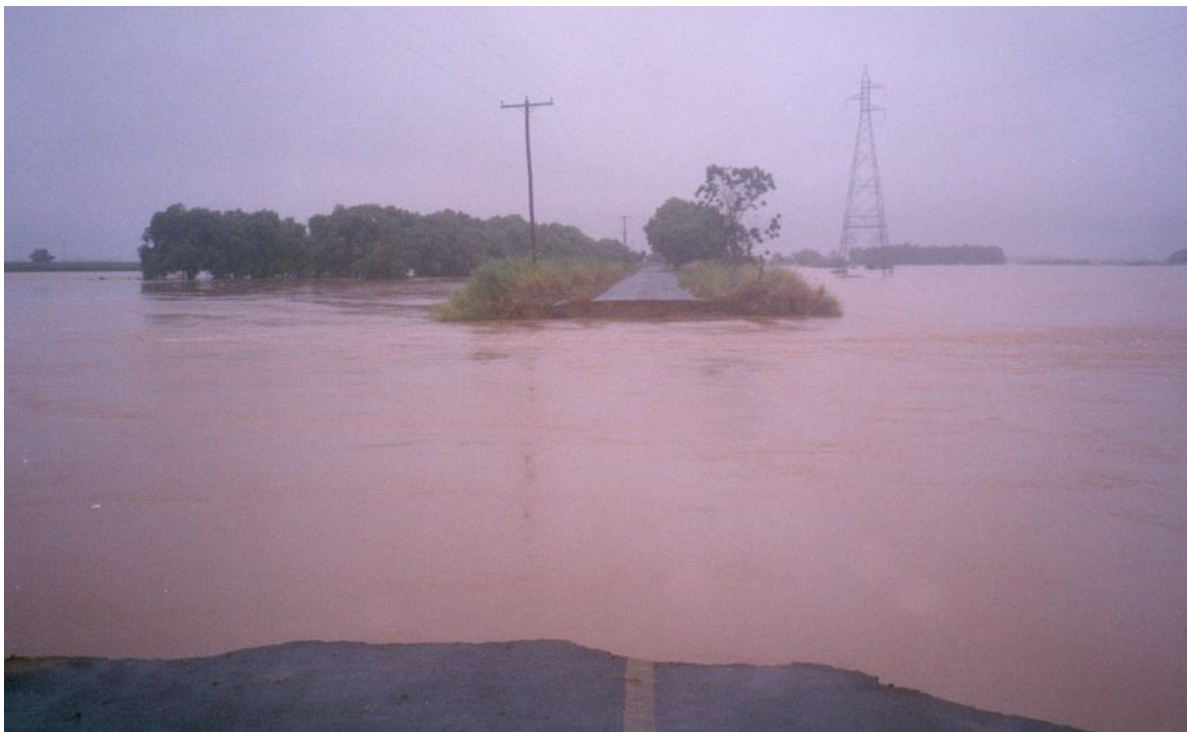
Foto 1 – Rompimento do dique da margem esquerda do rio Paraíba do Sul durante o evento de inundação deflagrador de desastre ocorrido em janeiro/2007. O sentido do fluxo da corrente é da direita para a esquerda.
