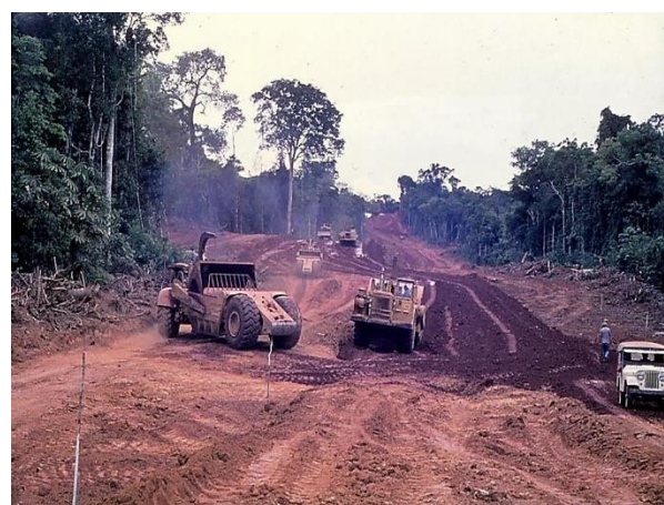
Construção da Transamazônica (06/09/1973). Fotografia: Gerd Kohlhepp.
