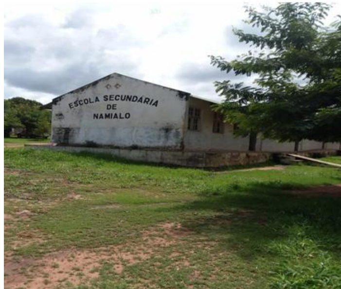
Figura 2 - Vista parcial do bloco principal da Escola Secundária de Namialo.
