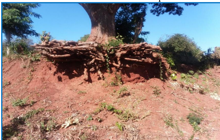
Figura 8 - Processo erosivo observado durante a aula de campo.
