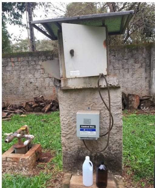
Figura 3 - Imagem do poço do imóvel.
