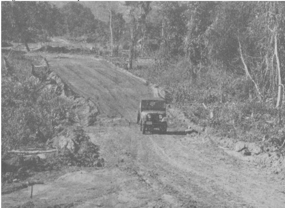
Imagem 1: Início de construção da Estrada Santo Aleixo-Piabetá.
